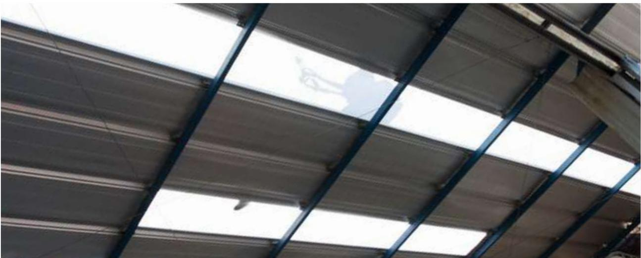
Nosso sistema ZIPLAN®, **permite a confecção de janela de iluminação** - quando se utiliza a telha translúcida no centro do telhado distribuindo os pontos de iluminação.
